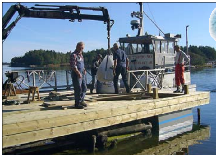
Montering av bryggga från Moderna Brygggor. Ny stenkista längst ut.
