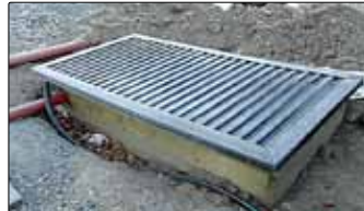
Utrymme för slamavvattnare, lite markarbeten återstår.
