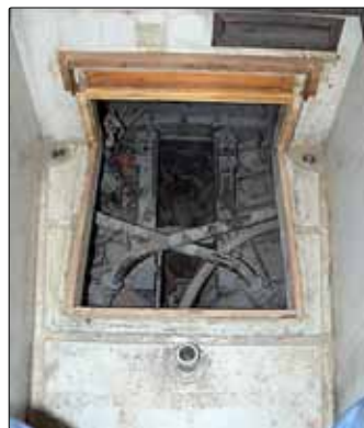
5. Det förstörade durkhålet med avrinning.
