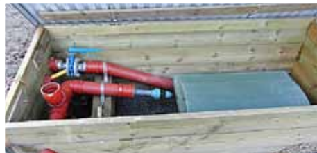
Shuntventil för regnvatten och behållare för slamavvattnare.
