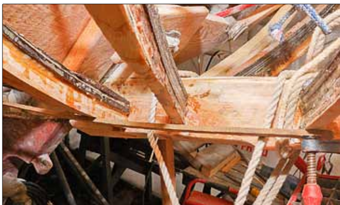
1. Stor skillnad mellan uttunnande och ännu inte åtgärdade spant.
