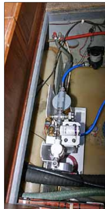
De tre filtren med datstyrenheten smyger fint in i utrymmet vid bränsletankarna.
