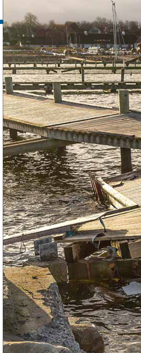
Många bryggor, med tillhörande el- och vattenförsörjning, bröts loss och flöt iväg under ovädret. Nu återstår ett mödosamt arbete för att återställa hamnen i tid till turistsäsongen.
