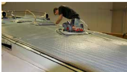
5. Förberedelse för vakuumsugning av rufftakssektionen. Nät och plast läggs över däck och tätas med butylband runt om. Sedan skapas ett tryck på däck på ca 8 kg/m 2 som får limmet att fördela sig jämnt mellan däck och teak utan risk för framtida läckage.
