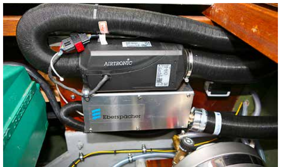
Värmaren är monterad på en "låda" i rostfritt som är lätt att skruva fast i ett skott och som döljer flera av slanganslutningarna. Översta slangen tar in friskluft från utsidan av motorrummet.
