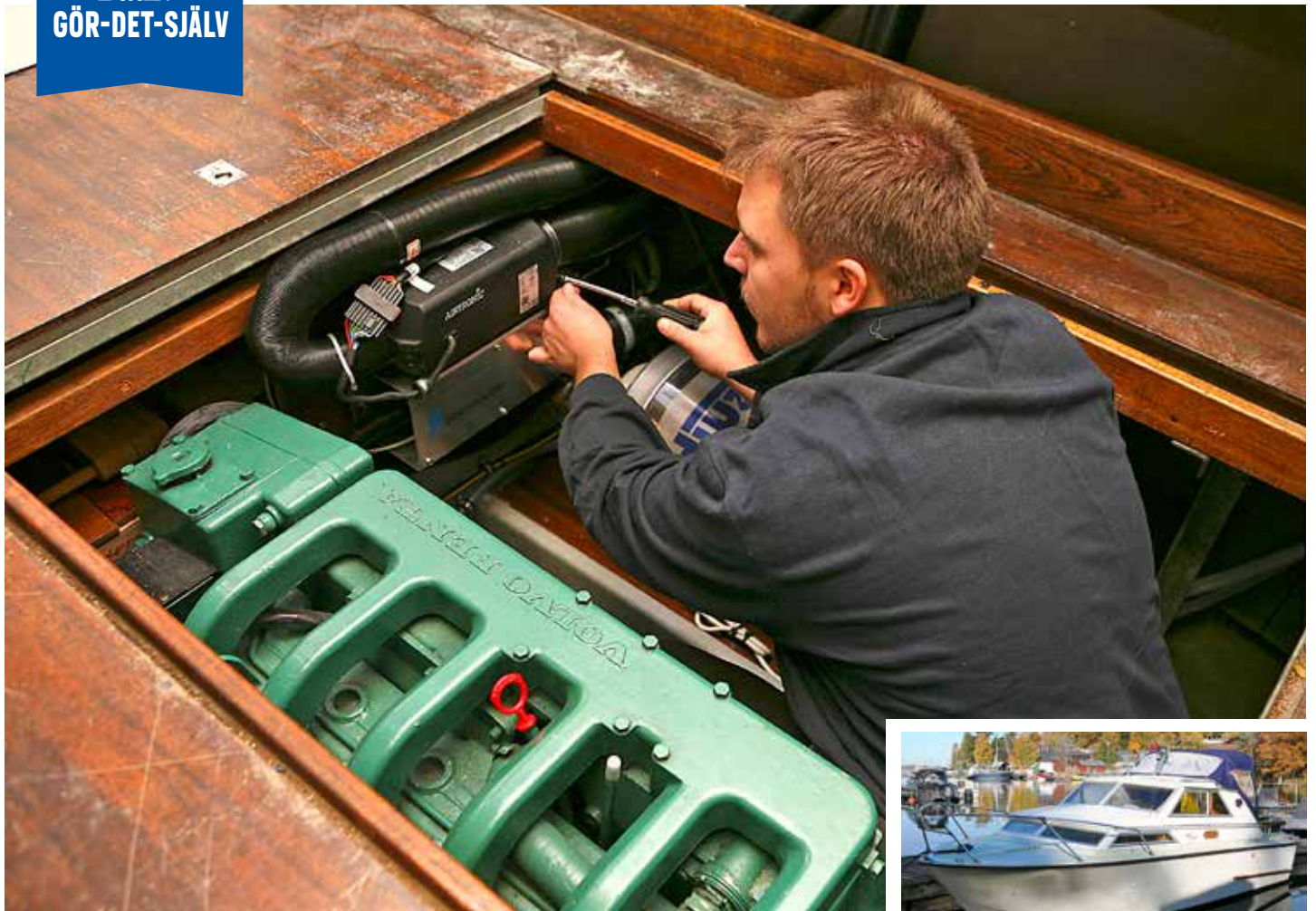
Vår Coronet 24 är utrustad med en dieselmotor. Då är det fullt godkänt att montera ett varmluftsaggregat i motorrummet.
