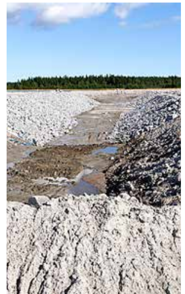
Bondökanalen genom Bondön i Piteås södra skärgård tar form.
