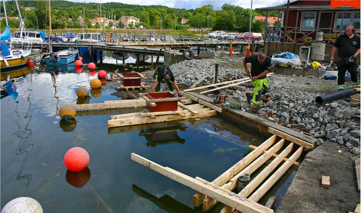
Ljungskile Båtklubb har invigt sin hamn efter en omfattande renovering, där bland annat en stor del av hamnområdet höjdes över 70 cm.
