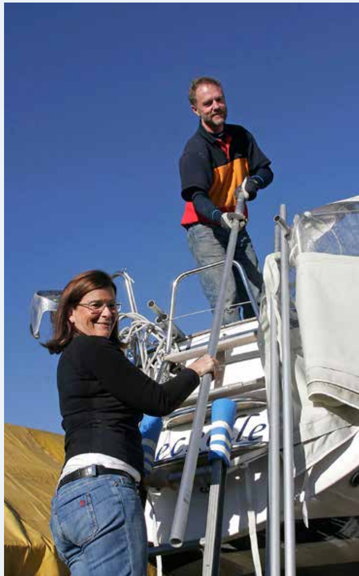
Birgitta och Jan Roeck-Hansen bygger täckning.
