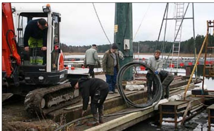
Arbetet med sugtömningsanläggningen är i full gång.
