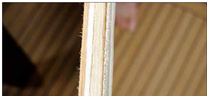
Teakdurkarna består nu av både gammalt och nytt i flera lager med god ljuddämpning. På bilden ser vi en genomskärning av durkarna.
