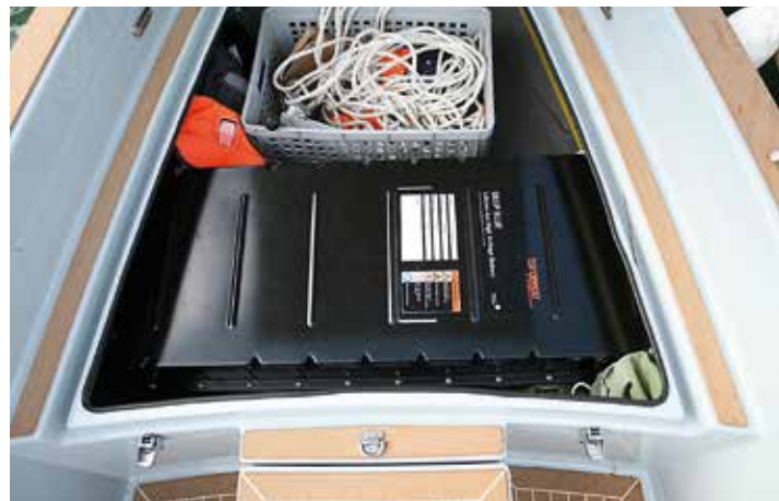
Batteribanken med två Litiumjon-batterier ligger centralt placerade i båten för att få bästa gångläge.
