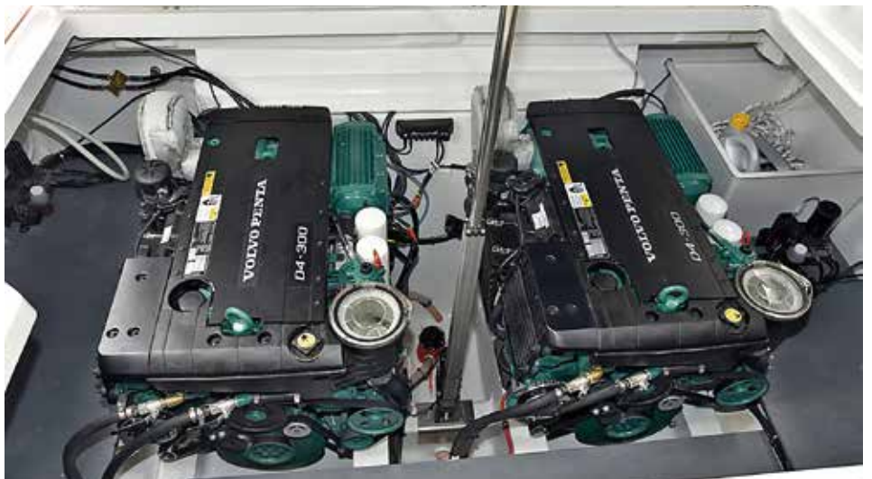
Motorrummet är rymligt och välplanerat med lätt åtkomliga servicepunkter. Ännu bättre hade det varit med en stege ner och förvaringsfack för småsaker på sidorna.
