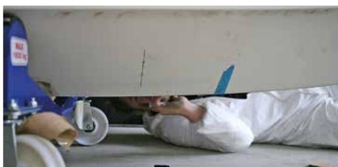
1. Börja med att märka upp en önskad plats för tunneln. Borra sedan ett par pilothål ovanför varandra på ena sidan. Detta är viktigt för att kolla så att man hamnar rätt inne i båten.
