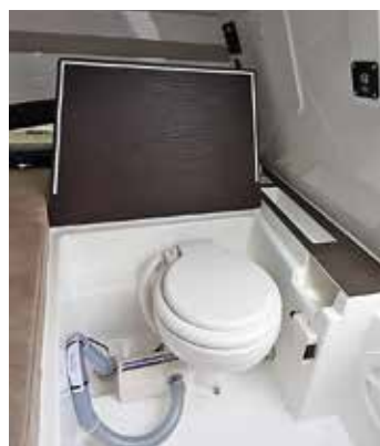
Sjövattentoaletten i kabinen.
