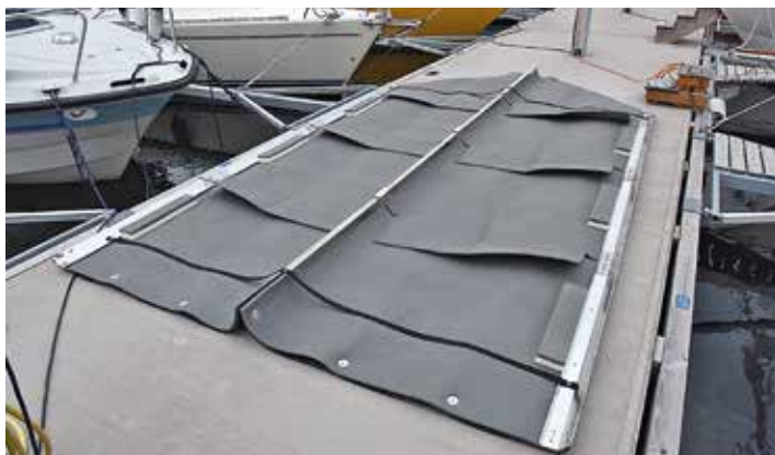
Skrovduken monteras först på bryggan, där ramen i aluminium skruvas samman. Därefter sjösätts duken och förtöjs "löst" vid båtplatsen.
