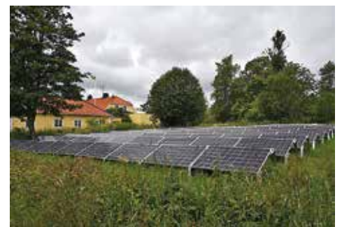
Solcellsparken med 90 solpaneler ger 25 procent av öns elbehov.
