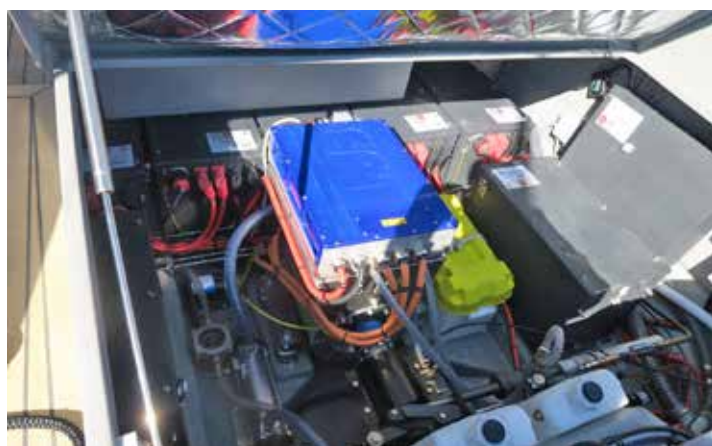
Motorrummet med motor, kablage och batterier.
