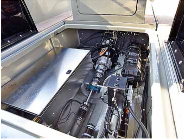
Under durkarna döljer sig drivlinan med en 220 kW (300 hk) motor, inverter och laddare från Brusa. Här finns också 2x60 kWh batterier från Kreisel.
