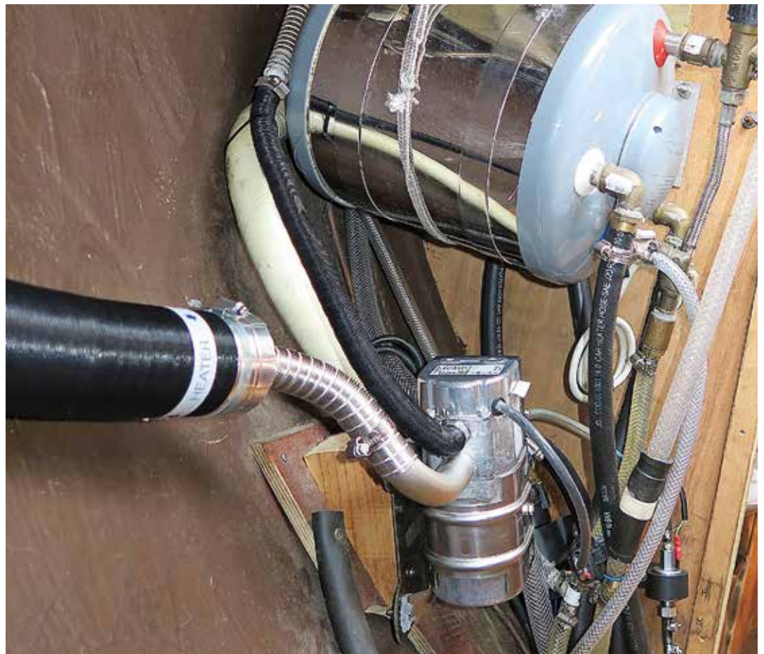
Den nya dieselvärmaren (nederst i bild) installerad i båten. Ovanför den syns varmvattenberedaren.
