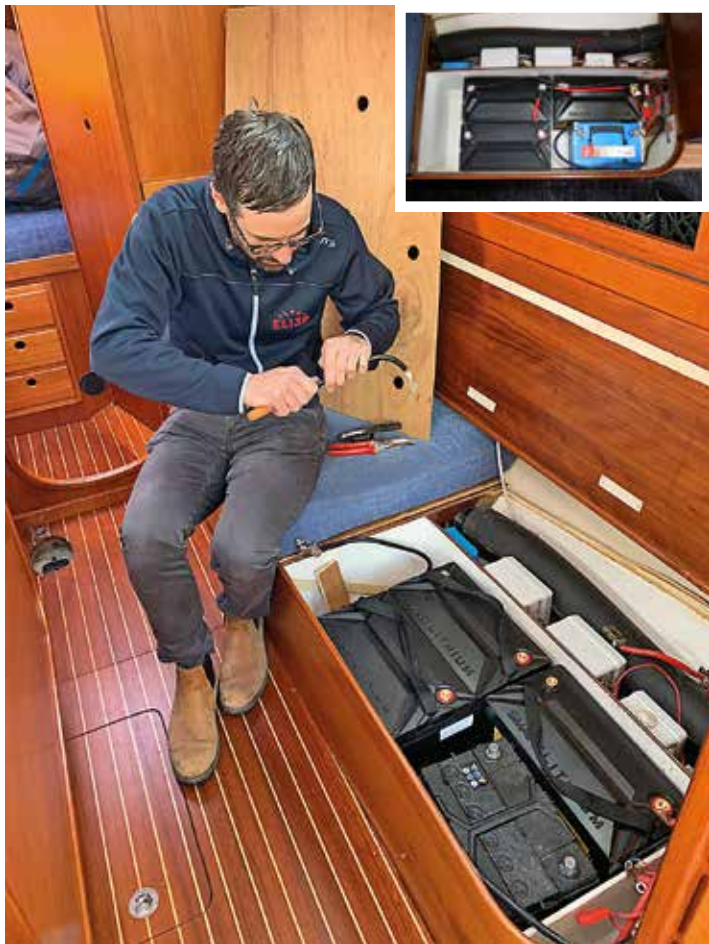
Det enda installationsarbetet som krävdes för de nya batterierna var anpassning av kabellängder och nya anslutningar.
