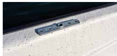
Enklart tänkbara infästning för årklykorna med popnit.
