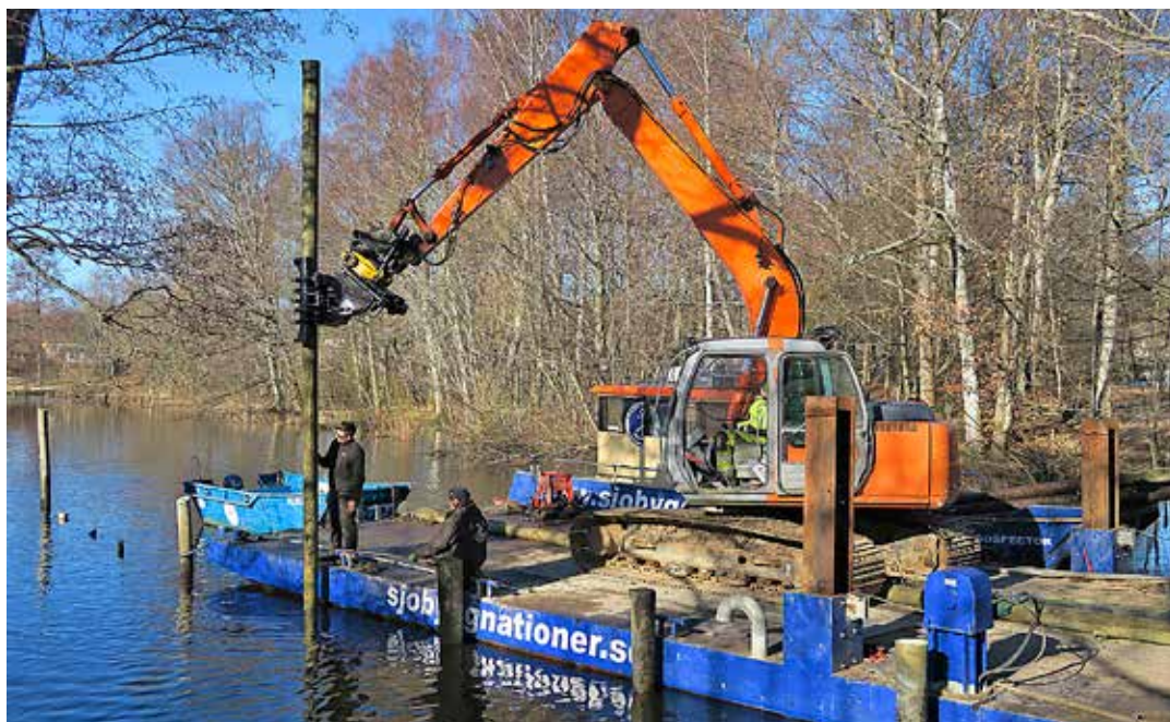
Grävmaskinen på sin pråm för att banka ner ytterligare en stock. Därefter kapas alla stockar så att ändarna har samma höjd över sommarens vattennivå.
