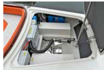
Installationen av laddare och styrningens upphängning är snyggt utförd i den stora motorbrunnen.
