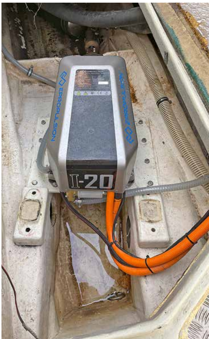
En av de eldrivna motorerna på 20 kW från ePropulsion, monterad i den gamla motorbädden. Axel och propeller har man behållit.
